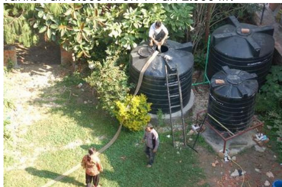
Bijkomend probleem, omdat de tankopening hoger is dan de afvoer van de vrachtauto die het water levert, dat je een motor moet hebben om het water hoger te pompen, dus geduld hebben, want op het tijdstip van levering was er weer eens geen stroom.
